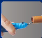
① 铜管去毛刺, 硬管需退火处理
